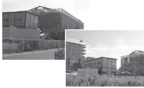
▲市立病院敷地内に建設中の(仮称)湖東地域医療支援センター
